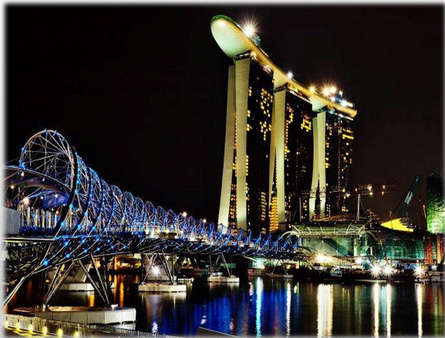
СИНГАПУР – Хеликс мост
